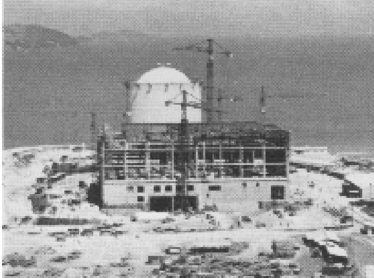
Outro exemplo de obra gigantesca: a usina nuclear Angra I.
